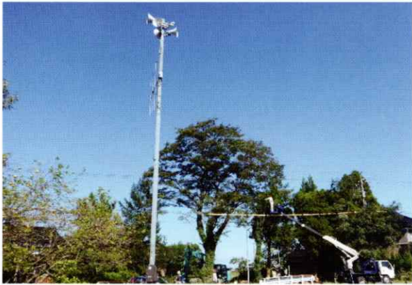
市内の防災無線アンテナ
